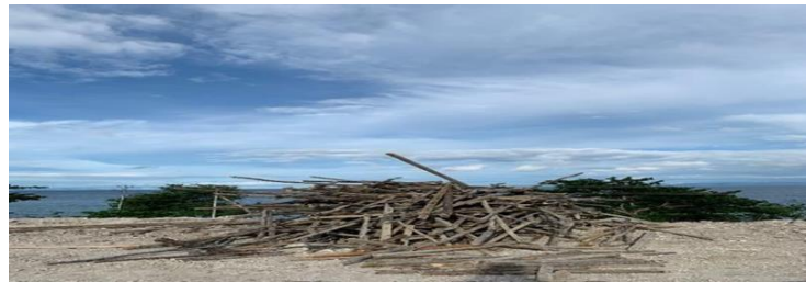
Gambar 3. Material sisa kayu (bekesting)
