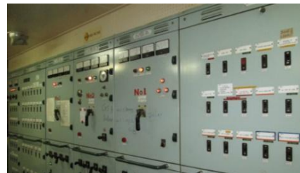
Gambar 11. Keluaran daya listrik dari setiap Generator dan 4 jumlah panel Generator
