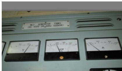
Gambar 11. Keluaran daya listrik dari setiap Generator dan 4 jumlah panel Generator
